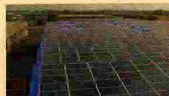
Impianto Inblu 400kWp realizzato nel 2009 da Eusun a Verolanuova (Bs)
